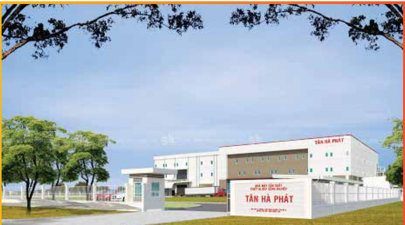
Nhà máy sản xuất thiết bị bếp công nghiệp Tân Hà Phát
